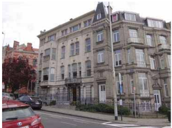
図3 ブリュッセル事務所のある建物の外観
