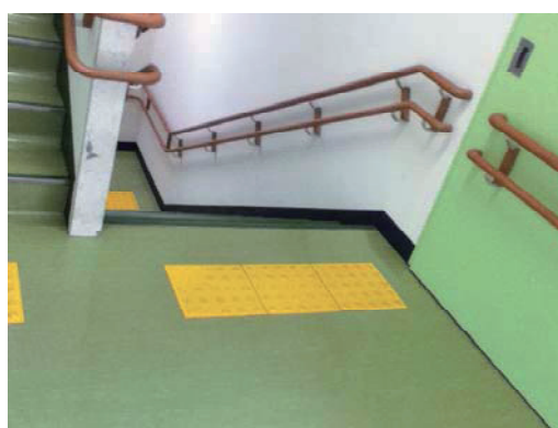
写真4 点字誘導ブロックと手すり
