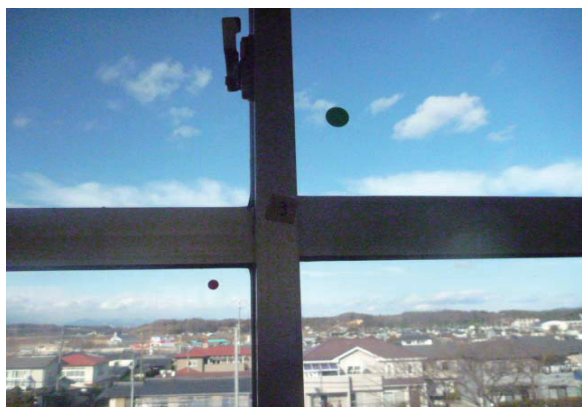
写真10 シールが貼られたUVカットフィルムガラス
