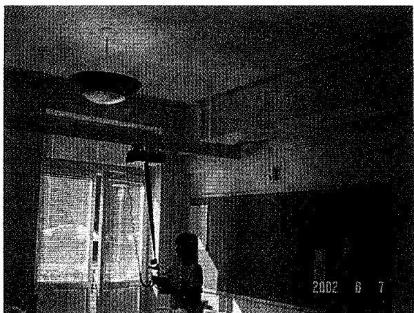
図3 室内移動用リフトの例（リフトが下がっているレール自体がスライドするので室内全域を移動できる：ストックホルム・モッカジーネン・トレーニングスクール）
