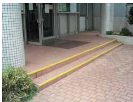
テープ設置後
