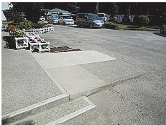
写真6 保護者の車幅に合わせて継ぎ足した車寄せ用スロープ
