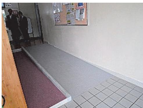
写真5 導線を考慮して設置した玄関のスロープ
