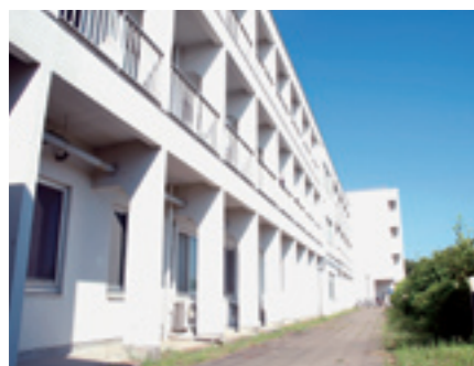
写真：宿泊棟外観，宿泊棟居室，食堂
