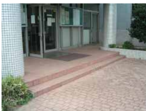
テープ設置前
